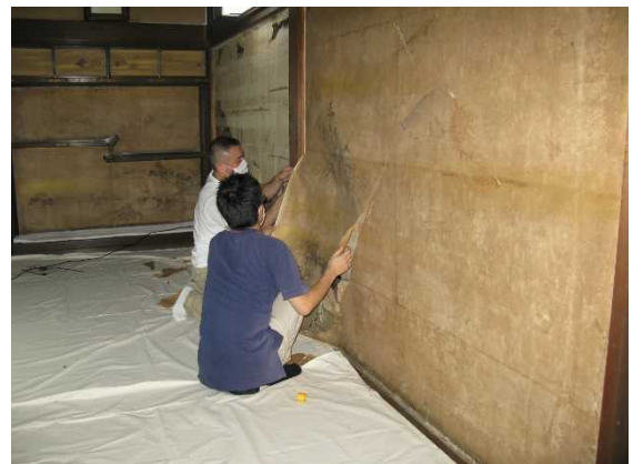
障壁画修理の様子
