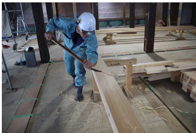
古式の木工技術による修理の様子
