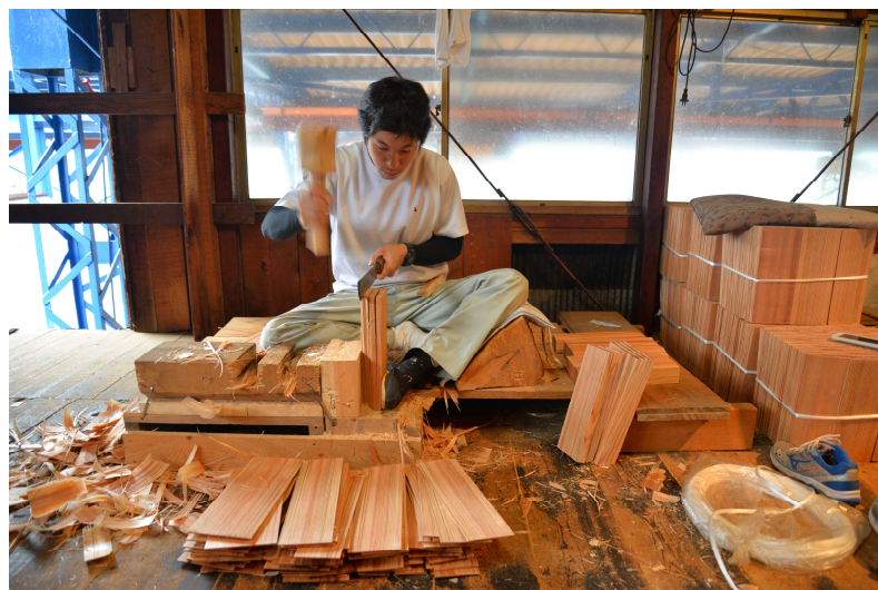
屋根板製作の様子
